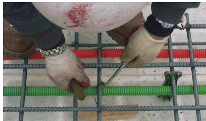
2. 슬라브 타설 전 상부근과 하부근 사이로 배관하여 상부근에 고정함
