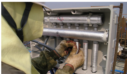
7. 분배기 배관 연결시 보온작업 병행
