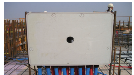
9. 분배기 BOX 보양커버 고정 시공
